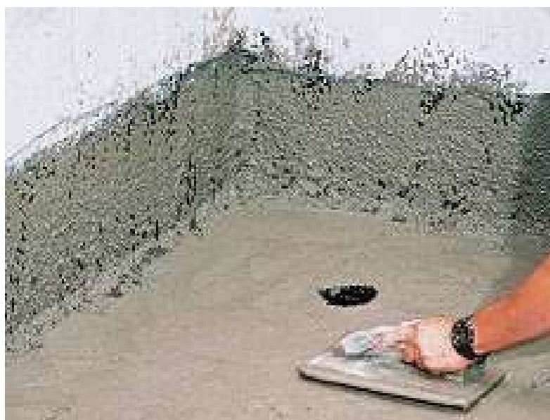
Figura 6: Aplicação de Argamassa Polimérica em forma de revestimento.
