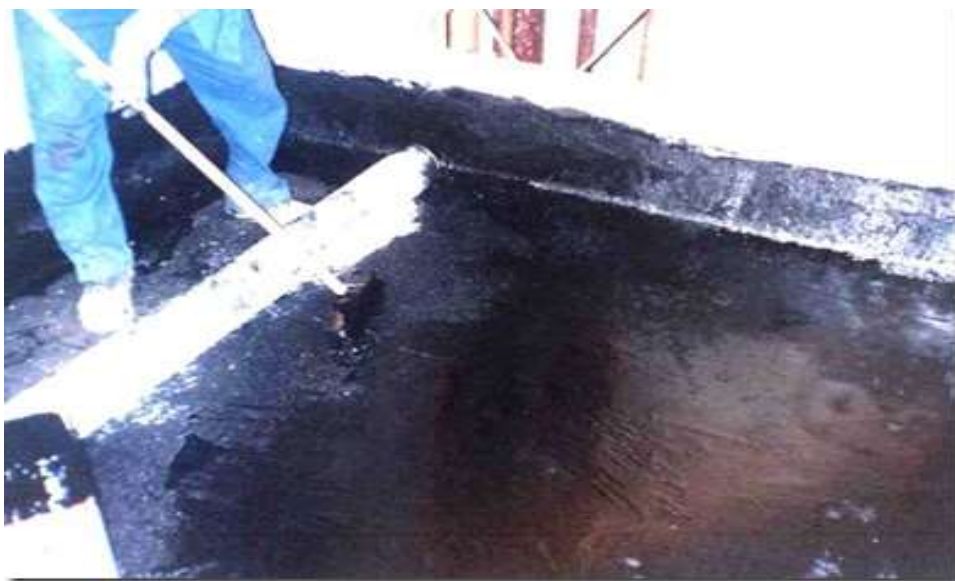
Figura 7 - Aplicação membrana asfáltica a frio
