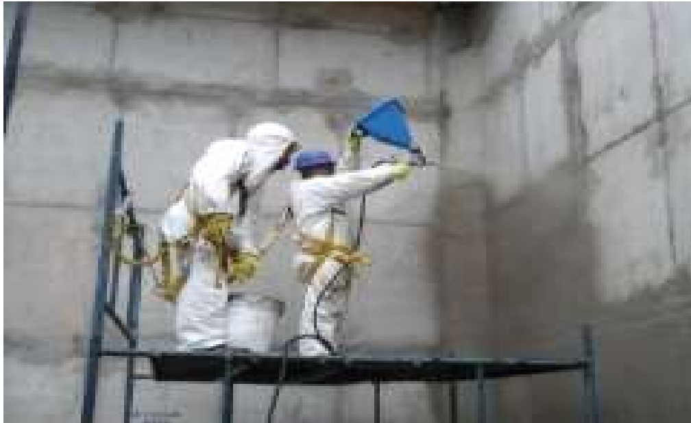
Figura 3 - Aplicação de Cristalizantes em forma de jato.
