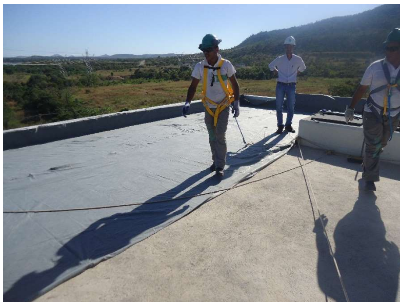
Figura 11 – Aplicação manta PVC
