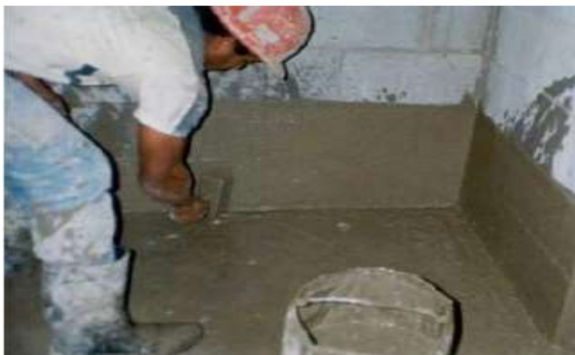
Figura 9 - Aplicação da membrana asfáltica acrílica.
