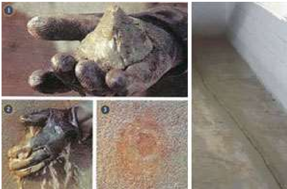
Figura 4 - Aplicação de Cimento de pega ultra – rápida
