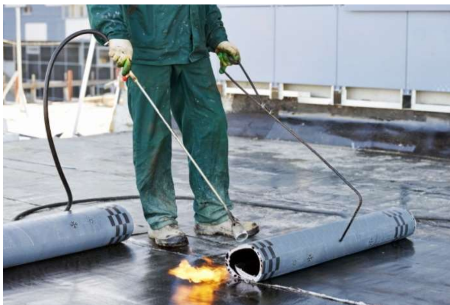
Figura 10 - Aplicação da manta asfáltica
