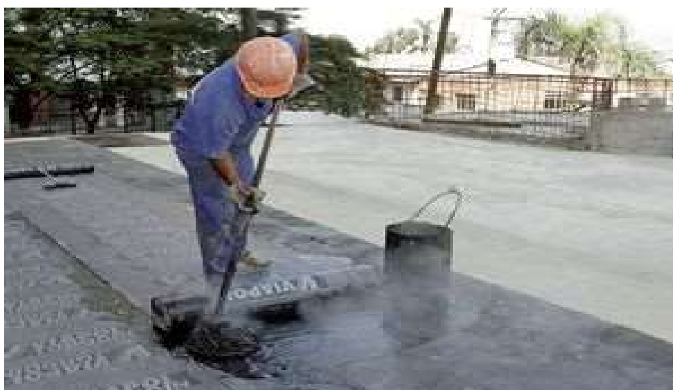
Figura 8 - Aplicação da membrana asfáltica à quente
