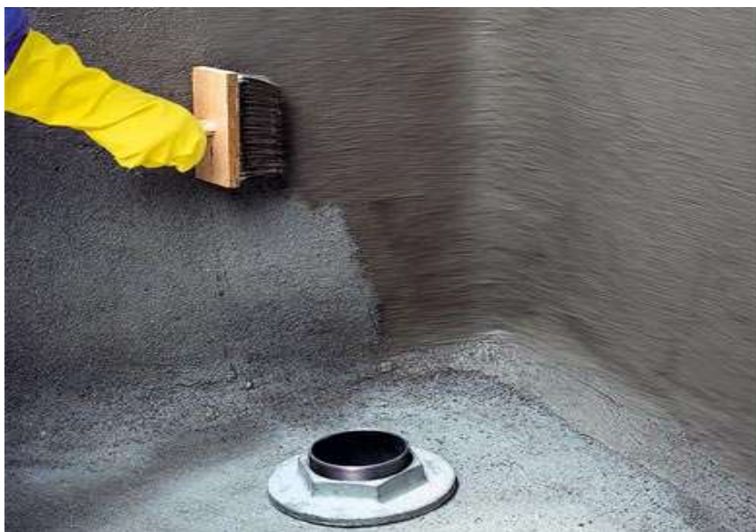
Figura 5 - Aplicação de Argamassa Polimérica em forma de pintura.
